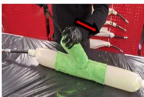
14. Senken Sie den Druck auf 0,1 -0,2bar. Falten Sie mit Hilfe der Inversionsstange den seitlichen Blasenteil und schieben Sie ihn mit der Anschlussmanschette in den Blasenkörper. Stellen Sie sicher, dass sowohl die Blase als auch der seitliche Teil der Anschlussmanschette eng aneinander anliegen. Dieser Schritt gelingt leichter, wenn der Blasendruck mithilfe des Pocket Vacuum angepasst wird.
