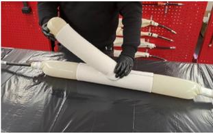
12. Sie können Luft ablassen und Anpassungen vornehmen, bevor Sie sie bei Bedarf wieder aufpumpen. Es sollten keine Falten oder verdrehten Stellen vorhanden sein. Fügen Sie mehr Luft hinzu, um die Blase mit bis zu 0,2bar zu beaufschlagen.
