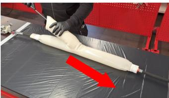
2. Befestigen Sie den Air Adapter und den Luftdruckregler am Installations-Tool. Drücken Sie bei leicht aufgepumpter Blase (0,1 bar) mit einem abgerundeten Stock oder einer Stange die seitliche Nase vollständig in die Blase.
