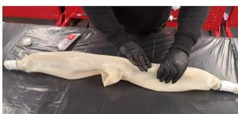
6. Das Blasentrennmittel verhindert das Anhaften künftiger Beschichtungen, Liner oder Punktrepaturen. Eventuell im Rohr befindliches Blasentrennmittel muss vor allen nachfolgenden Sanierungen entfernt werden.
