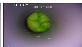
22. Wenn der abzweigende Teil der Anschlussmanschette so zentriert wie möglich ist, beginnen Sie, zusätzlichen Druck zu beaufschlagen, um die Blase vollständig zu befüllen. **Siehe Tabelle 1 oder Tabelle 2 (Aushärtung bei Umgebungstemperatur) oder Tabelle 3 (Dampfaushärtung).**
