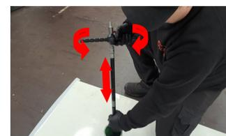
21. Schieben oder ziehen Sie zur Adjustierung der Position, während Sie den Drehgriff nach Bedarf drehen, um die seitliche Blasenöffnung auf die Anschlussöffnung auszurichten.
