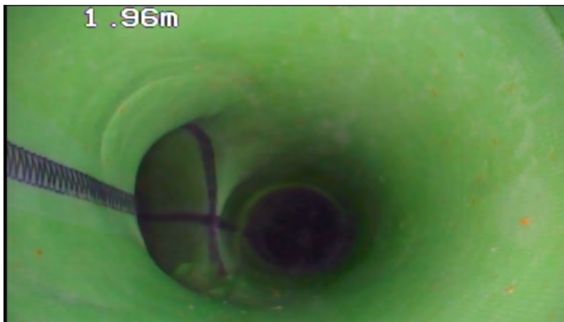
Sicht auf Hauptrohr in Fließrichtung
