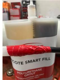
3. Mit Klebeband sichern. Setzen Sie die Kartusche in den Smart Mixer ein. Bringen Sie die statische Mischspitze an.
