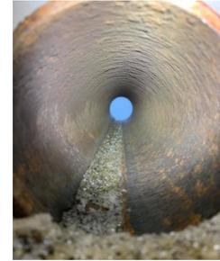
8. Überschüssigen Schaum in DN70 Rohren und größer mit einer Premium-Cyclone Kette entfernen. In DN50 Rohren und kleiner verwenden Sie den Mini Smart Sweeper oder Seitenschleifpanee. Säuberung durch Absaugung oder Spülung.
