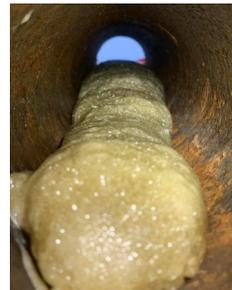
7. Drehen Sie den Smart-Mixer nach unten und pumpen Sie den Smart Fill in die Leitung. Lassen Sie ihn 15 Minuten einwirken.
